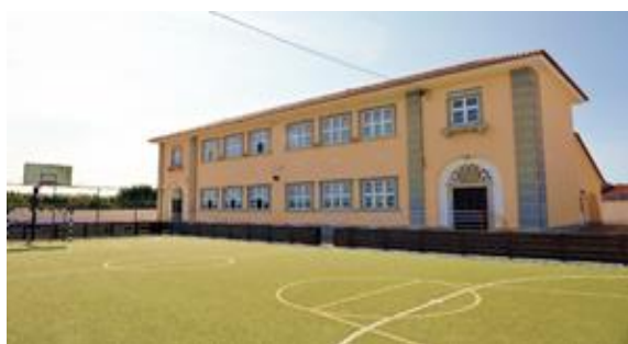
Figura 14 - Escola Básica de 1.º Ciclo de Ferrel – edifício 1
