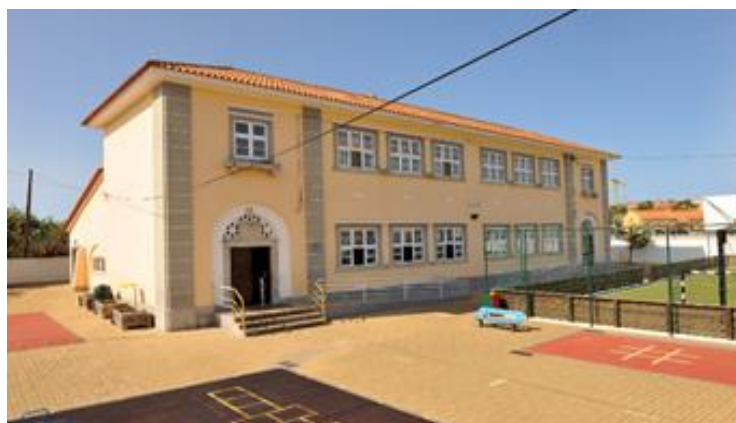
Figura 17- Escola Básica de 1.º Ciclo de Ferrel – edifício 1
