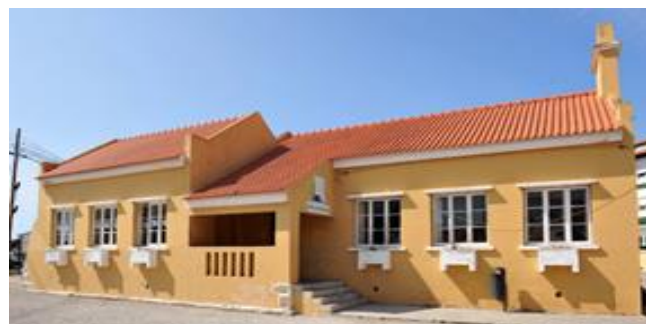
Figura 15 - Escola Básica de 1.º Ciclo de Ferrel – edifício 2
